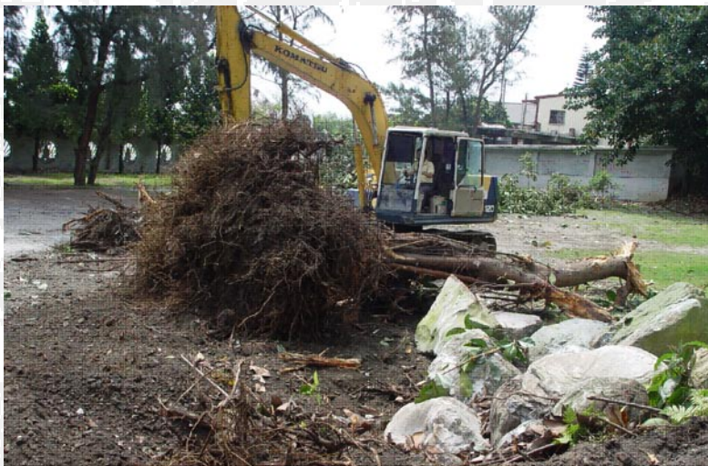
▲ 圖21. 以機具協助大型根部挖除及清理，再以人工方式檢除罹病殘根
