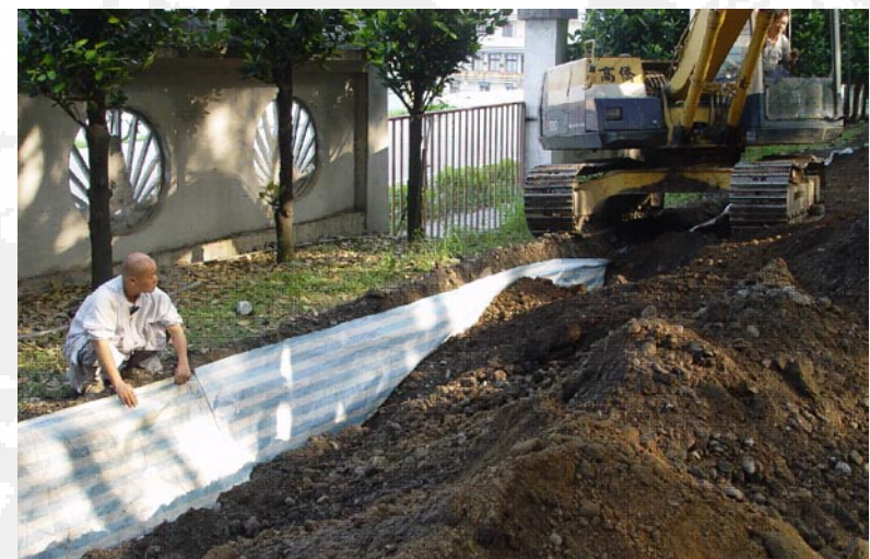
圖 6 阻隔溝之設置（鋪設強力塑膠布）
