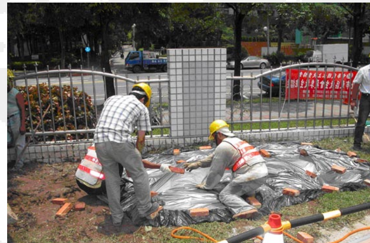
◀ 圖23 將燻蒸區域以厚膠布仔細覆蓋，並設立警告標示
